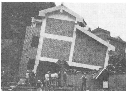
写真 3-33 2階で層崩壊した建物 B の妻面
