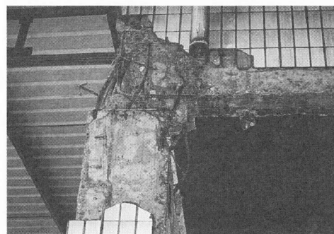
写真3-21 柱頭部の破壊
