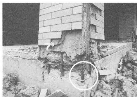
写真3-17 隅柱柱脚主筋の破断
