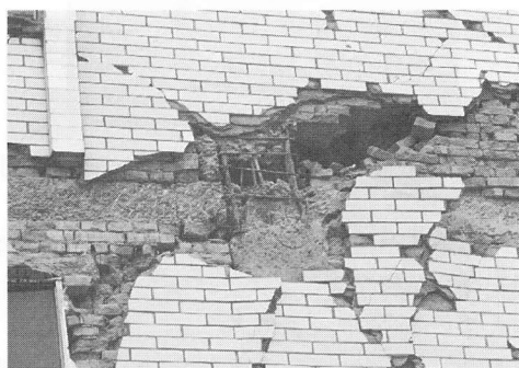
写真 3-7 レンガ壁と間柱のせん断破壊 (写真 3-6 の○部分の拡大写真)
