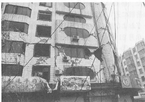
写真 3-5 レンガ壁の損傷
