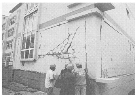
写真 3-8 繊維メッシュを用いたレンガ壁の被害
