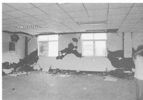
写真 3-10 室内側から見たレンガ壁の損傷 (メッシュシートなし)
