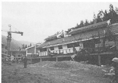
写真 3-34 2階で層崩壊した建物 B の道路 側正面 (1 階は RC 壁構造の駐車場)
