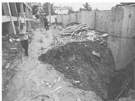
写真3-29 土砂の流出による地盤の陥没
