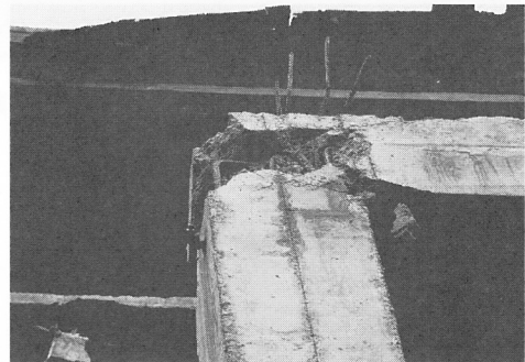
写真3-26 柱梁接合部のせん断破壊
