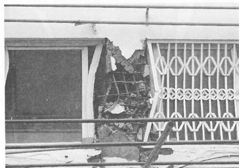
写真3-14 レンガ造腰壁による短柱のせん断破壊
