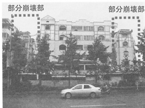
写真3-47 両妻側構面が部分崩壊した建物K (ほぼ同一形式の隣棟の一部が写真左端に見える)
