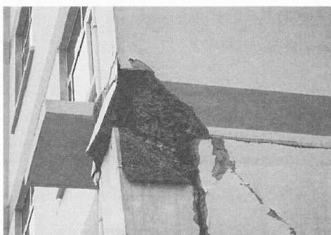
写真3-18 柱頭と柱梁接合部の損傷
