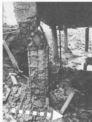
写真3-27 地盤変状による柱の破壊
