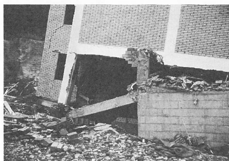
写真3-22 ピロティ柱の崩壊
